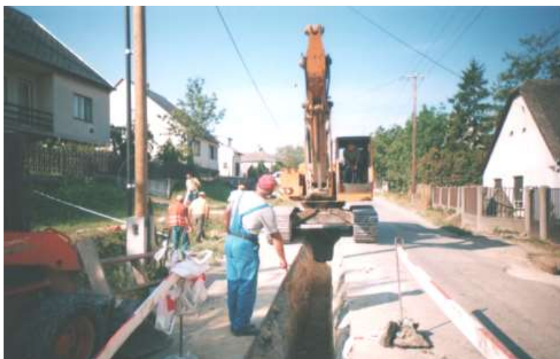
Csatornaépítés a Kossuth utcában
