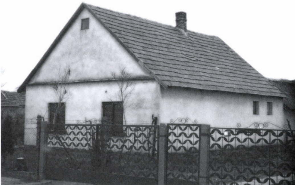
Eredeti formáját megőrző telepesház
