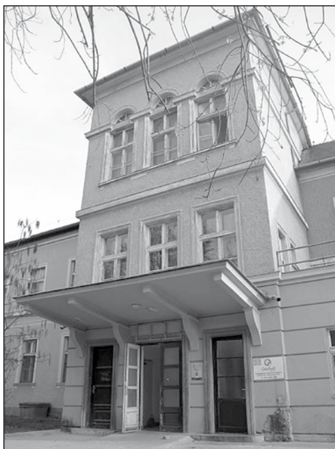
17. kép – Az Elmegógyintézet épülete. Északi homlokzat, főbejárat ill. lépcsőház, 2013. (A szerző felvétele)
